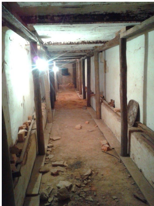
Figura 28 –Túnel do casarão da Rua Manaus – 2017
