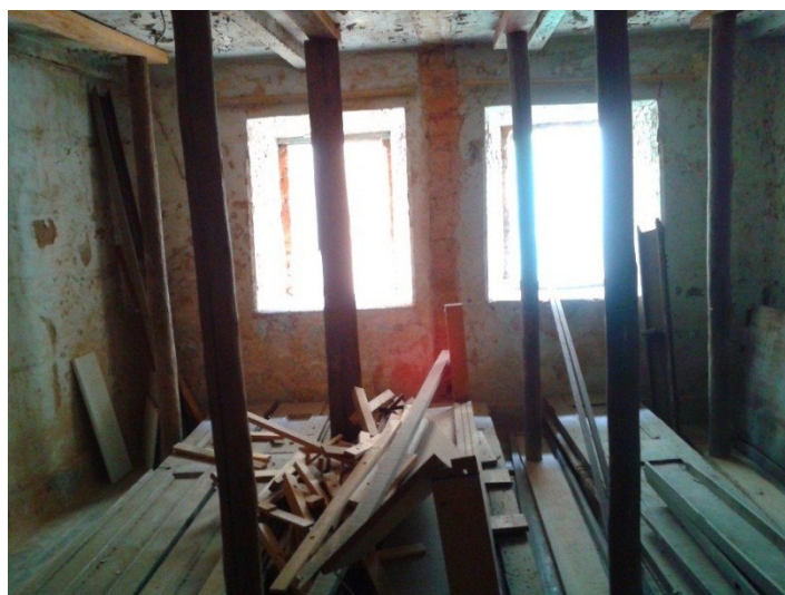
Figura 21- Escoramento do casarão- interior
