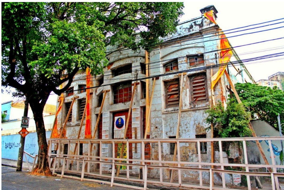
Figura 20- Escoramento do casarão- fachada
