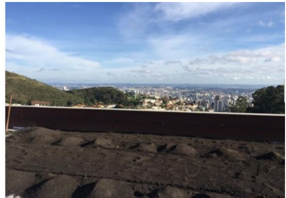
Figura 36 – Instalação do substrato na cobertura do Hospital Orizonti.
