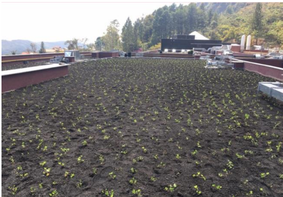
Figura 35 – Instalação de grama na cobertura vegetada do Hospital Orizonti.
