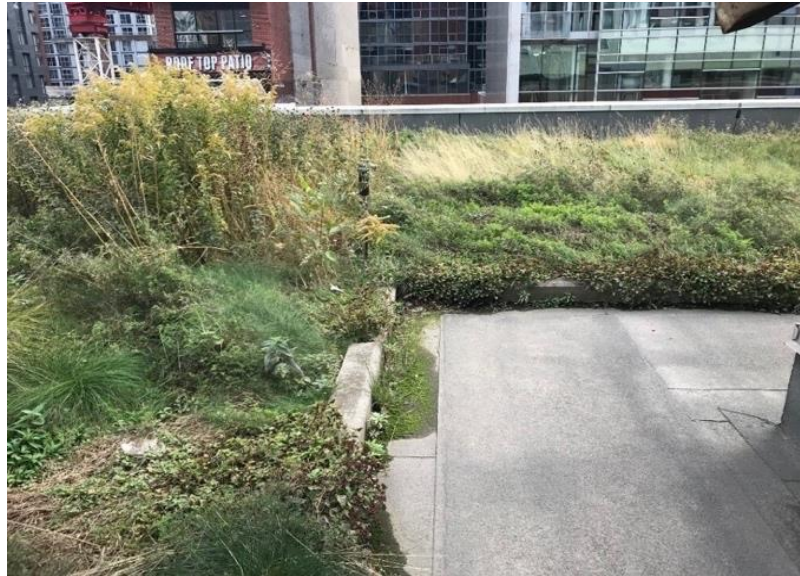
Figura 18 – Telhado vegetado da Mountain Equipment (Toronto, Canadá).
