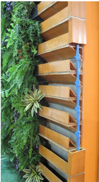
Figura 24a – Exemplo de sistema de irrigação periódica em parede viva modular, com potencial de atuação como contenção ativa das chamas. Fonte: Greenwall ceramic (2025)
