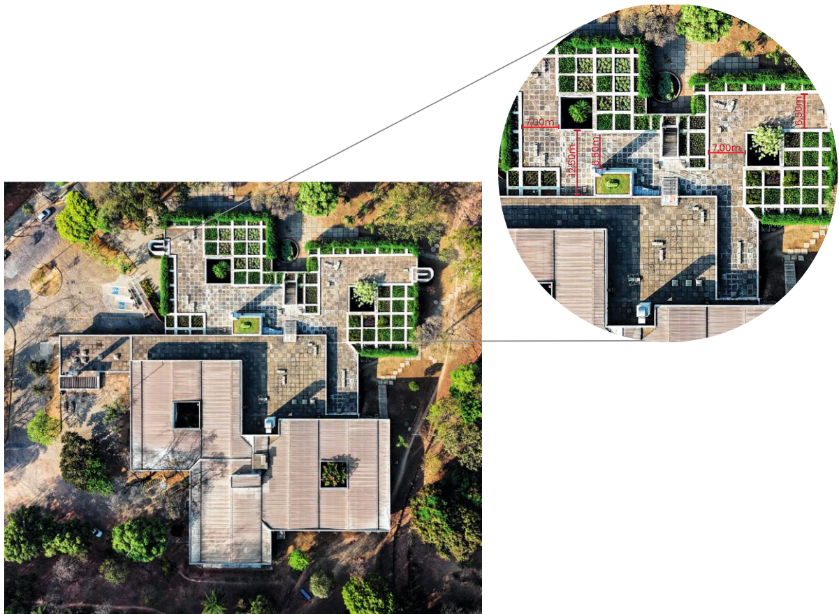
Figura 38 – Canteiros do Restaurante Setorial II da UFMG.
