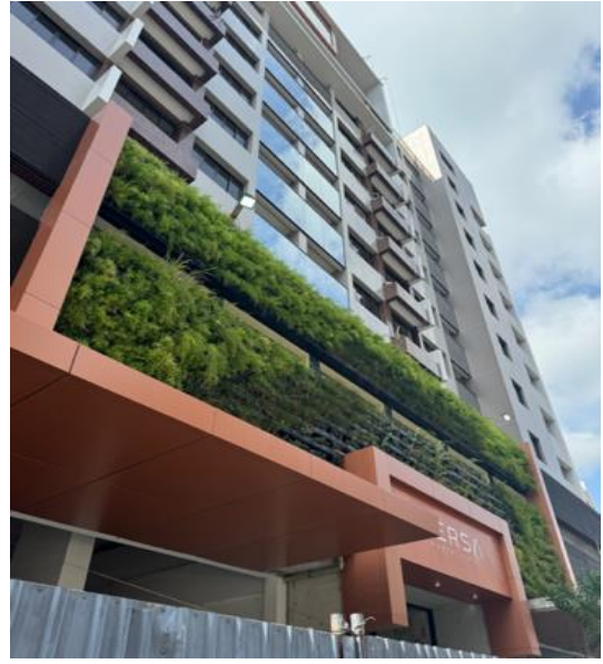
Figura 9b – Parede viva modular em um edifício em construção em Maceió, Brasil. Fonte: Autora (2024)
