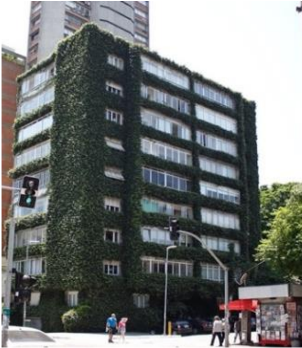
Figura 7a – Fachada verde direta - Condomínio Edifício Buritama em São Paulo. Fonte: Eduardo Okubo (2024)
