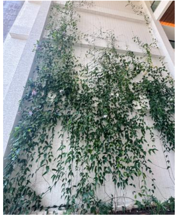
Figura 7b – Fachada Verde Indireta - Rede de cabos em edifício em Maceió. Fonte: Autora (2024)
