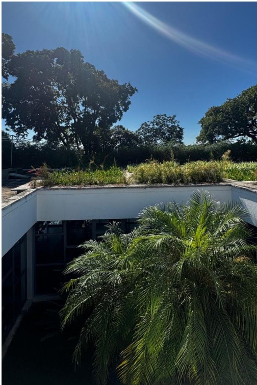
Figura 39 – Cobertura do Restaurante Setorial II da UFMG.
