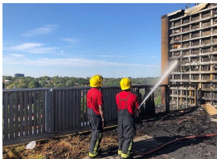
Figura 19 – Incêndio em fachada verde em Londres, Reino Unido (2018).
