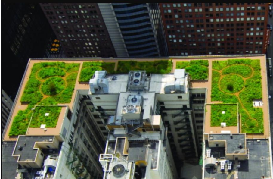
Figura 16 – Cobertura vegetada na sede da prefeitura de Chicago (EUA).
