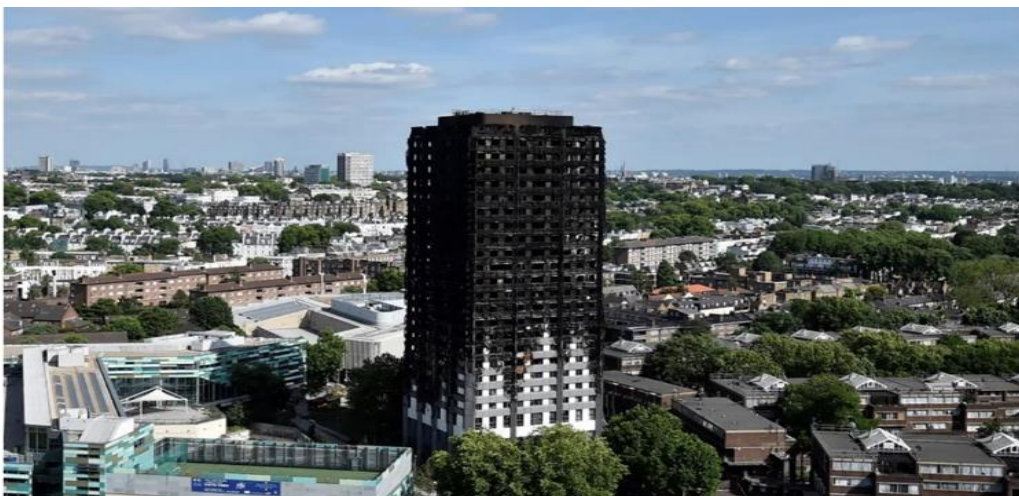
Figura 20 – Grenfell Tower, em Londres, após o incêndio ocorrido em 2017.
