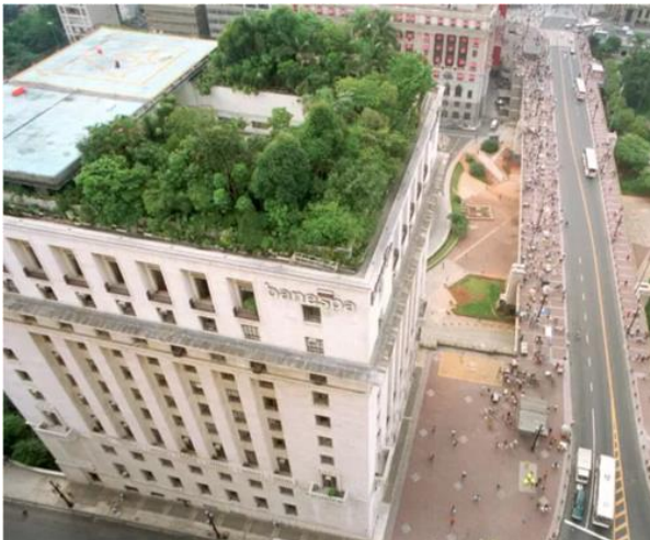
Figura 11a – Cobertura vegetada construído no edifício Matarazzo. Fonte: G1
