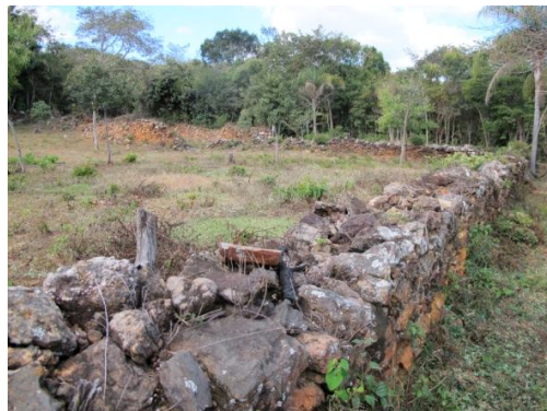
Figura 19 – Antigo muro de pedra de servidão desconhecida Fonte: Da autora
