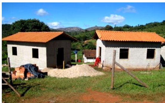
Figura 55 - Construção das sedes para associações na Barra da Cega Fonte: Da autora
