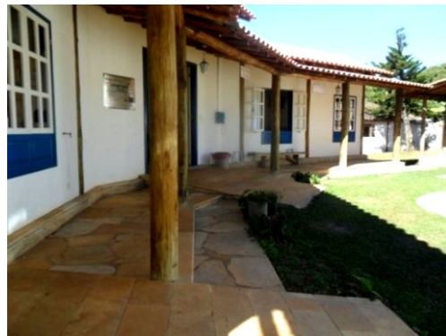
Figura 61 - Estrutura Centro de Informações Turísticas do Val, fora da APAEAV Fonte: Da autora
