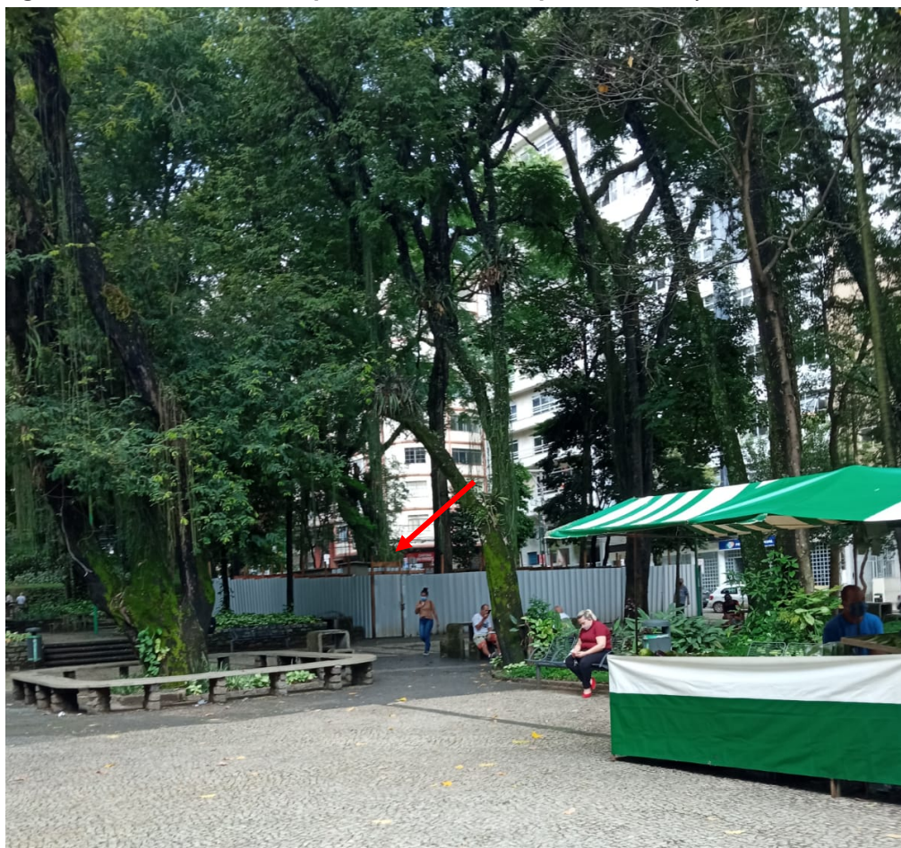
Figura 16: Banheiro do Parque Halfeld fechado para reforma (seta em vermelho).
