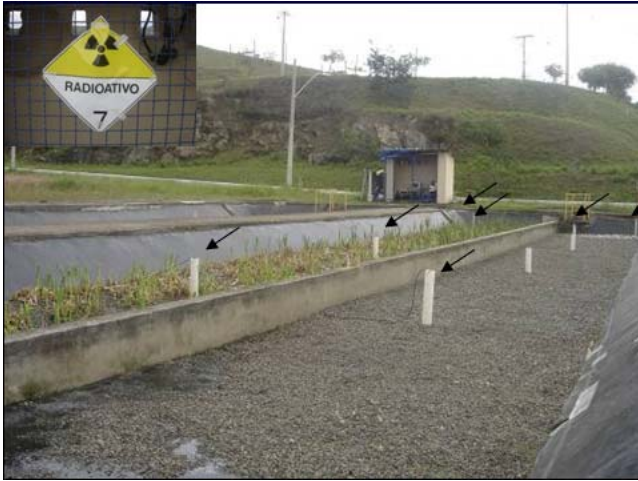
Figura 4.7: Pontos de localização das sondas que fizeram a leitura da radiação gama emitida pelo traçador e equipamento que armazenou os dados monitorados.
