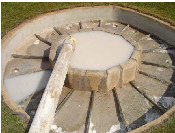
Figura 4.12 – Caixa de distribuição de fluxo
