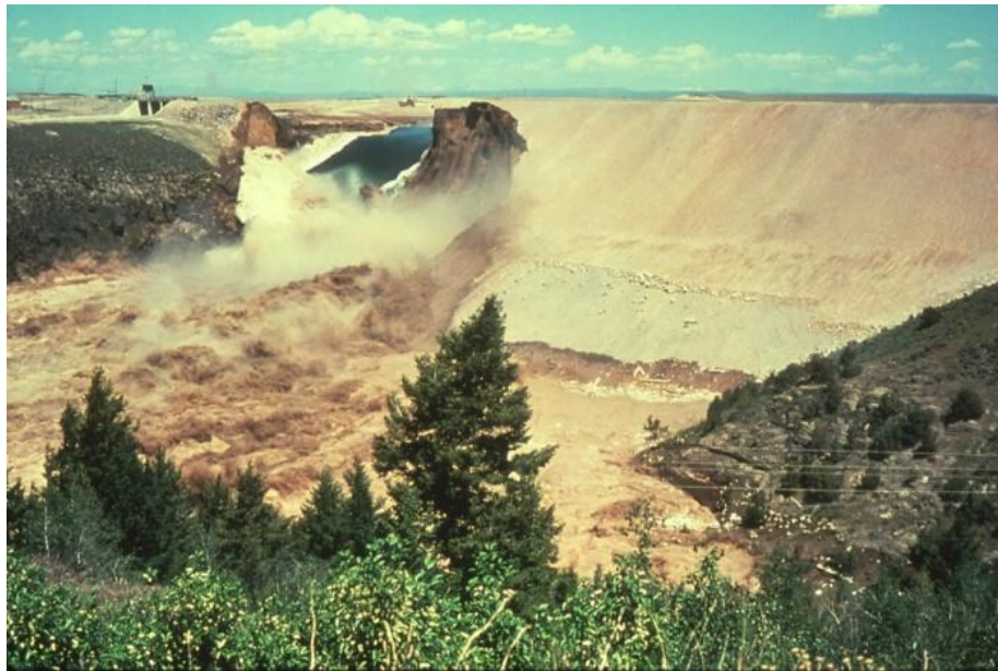
Figura 3.5 - Ruptura da barragem de Teton
