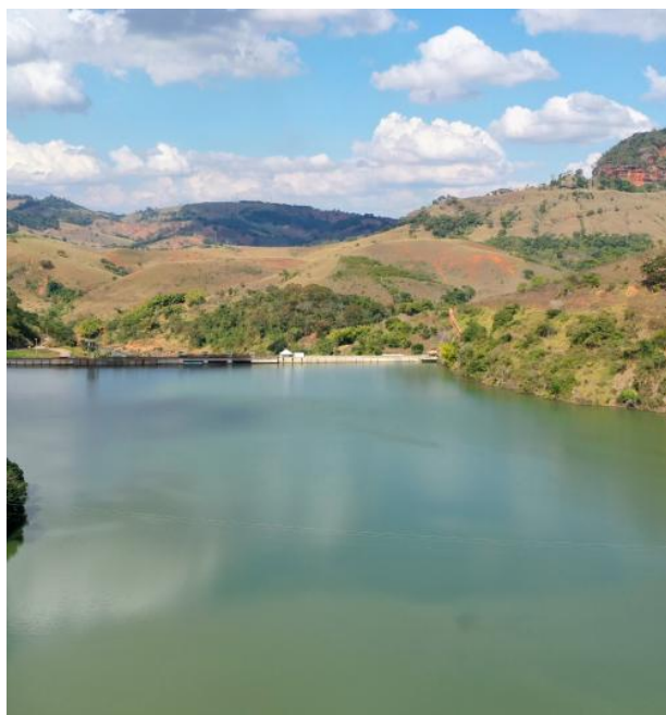
Figura 4 - Reservatório após fechamento das comportas e retorno operacional. Fonte: SAMARCO, 2023.
