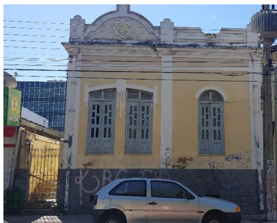
Figura 2 - Imagem frontal da edificação, com deformações.
