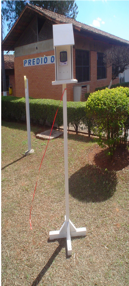
Foto 11: Abrigo meteorológico instalado na Escola Técnica
