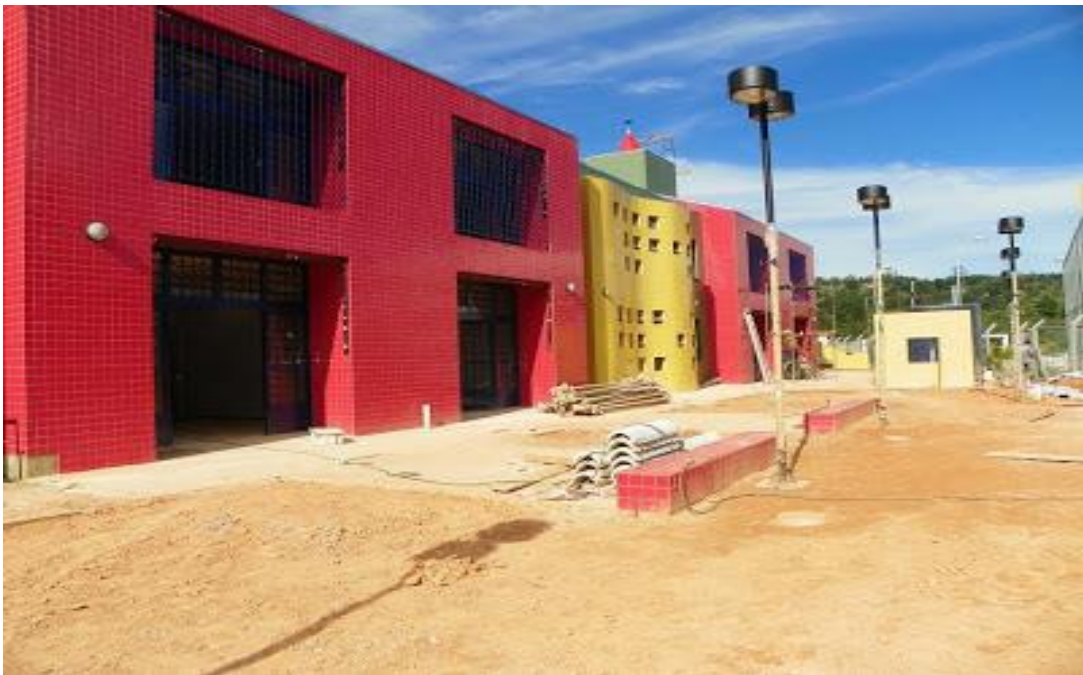
Figura 2: UMEI em fase de término da construção, 2010
