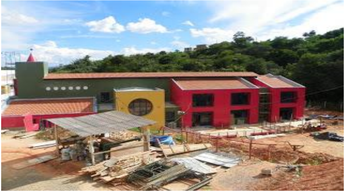
Figura 1: Início da Construção da UMEI
