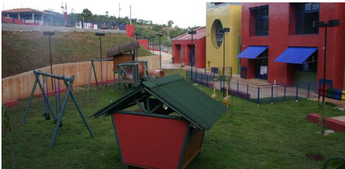
Figura 4: Obra pronta para inauguração em 2011
