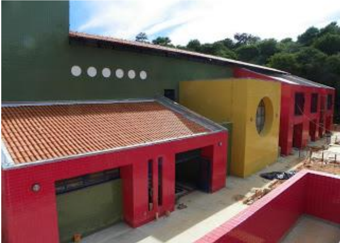
Figura 3 - UMEI em fase de término da construção, 2010
