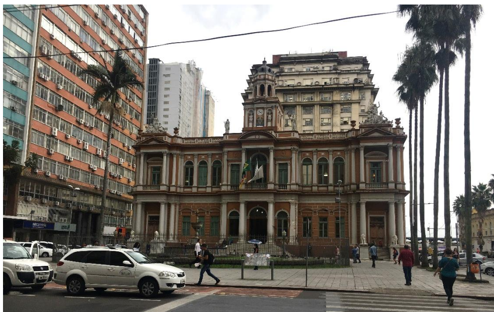
Figura 2 - Edifício da Prefeitura, Porto Alegre - RS.
