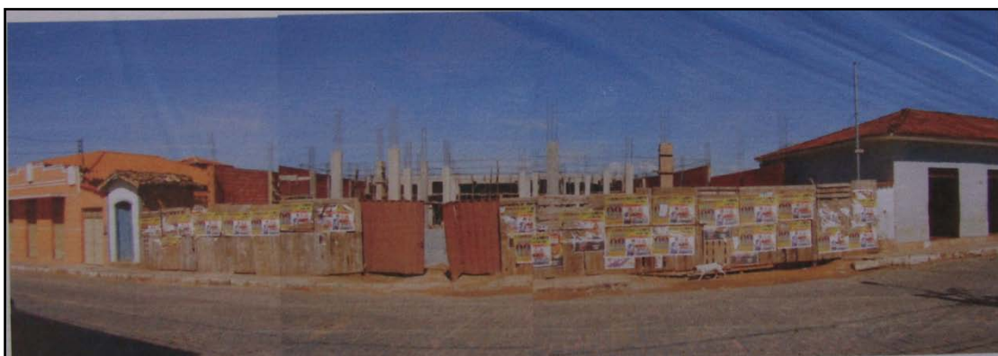
Figura 93. Configura-se a mais grave descaracterização do Núcleo Urbano Histórico. Em seu lugar será construído um shopping center. Fonte: Laudo técnico/2010. Honório Nicholls, 2010.
