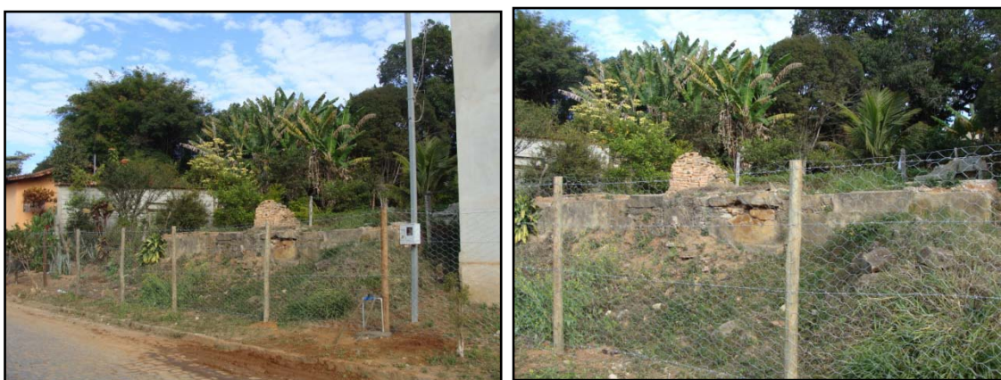
Figuras 62 e 63. Ficaram apenas rastros e destroços da casa destruída. Fonte: Ricardo Ferreira, 2014.
