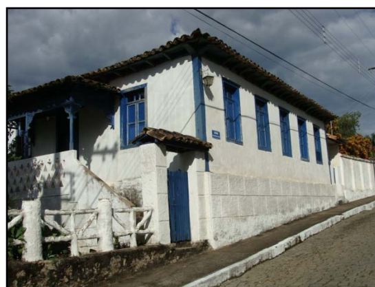
Figura 9. Imóvel com Porão Alteado ou Sobrado, situado à Avenida Dom Pedro II no Núcleo Histórico Urbano de Bonfim. Considerado como um dos mais antigos da cidade. Fonte: Ricardo Ferreira, 2012.
