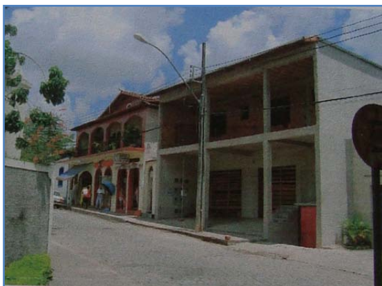
Figura 104. Edificação descaracterizante em fase de acabamento. Fonte: Laudo técnico/2010. Honório Nicholls, 2010.
