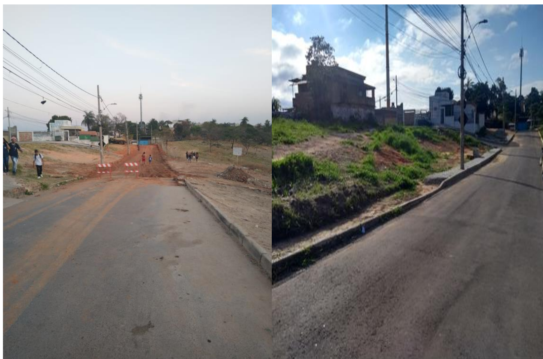
Figura 32: Asfaltamento da rua onde fica a escola, antes e depois – setembro 2019
