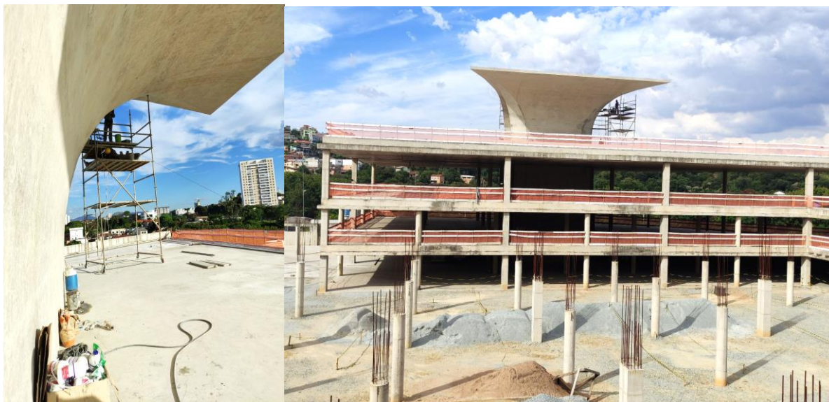
Figura 27: Construção altar externo
