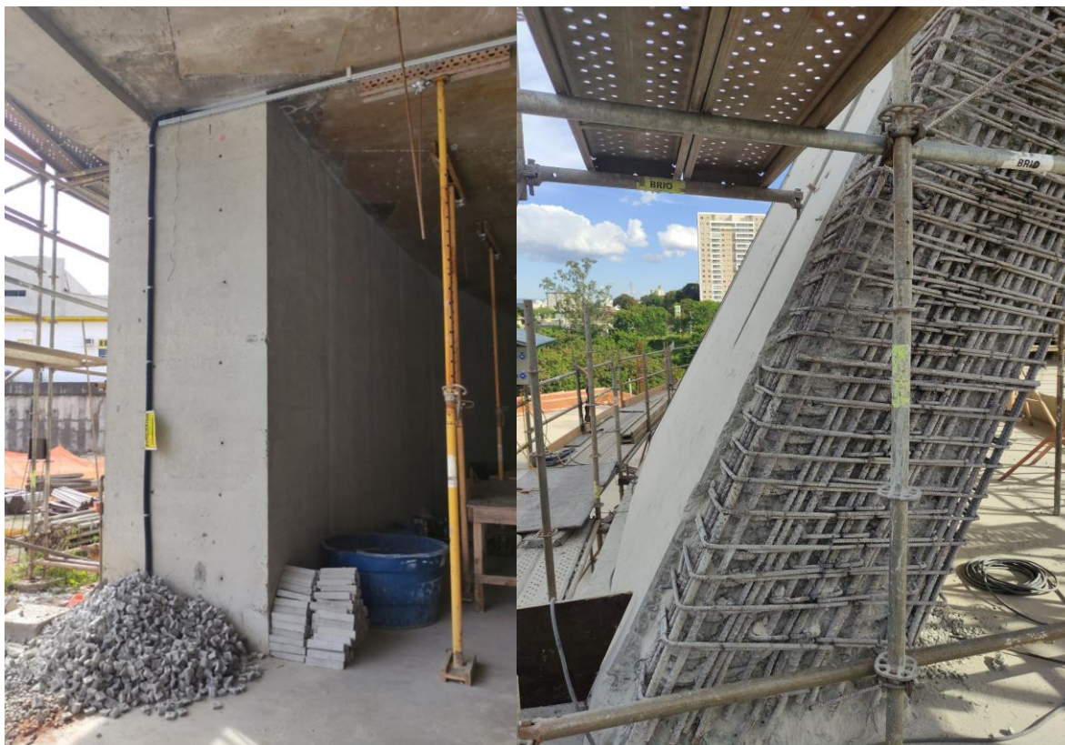
Figura 31: Parede dupla no prumo que inicia com 1,60m (à esquerda), e parede maciça de 1,0 quando começa a se curvar
