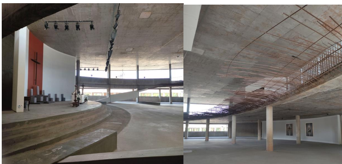
Figura 35: Vista do auditório inferior e local do auditório suspenso em construção
