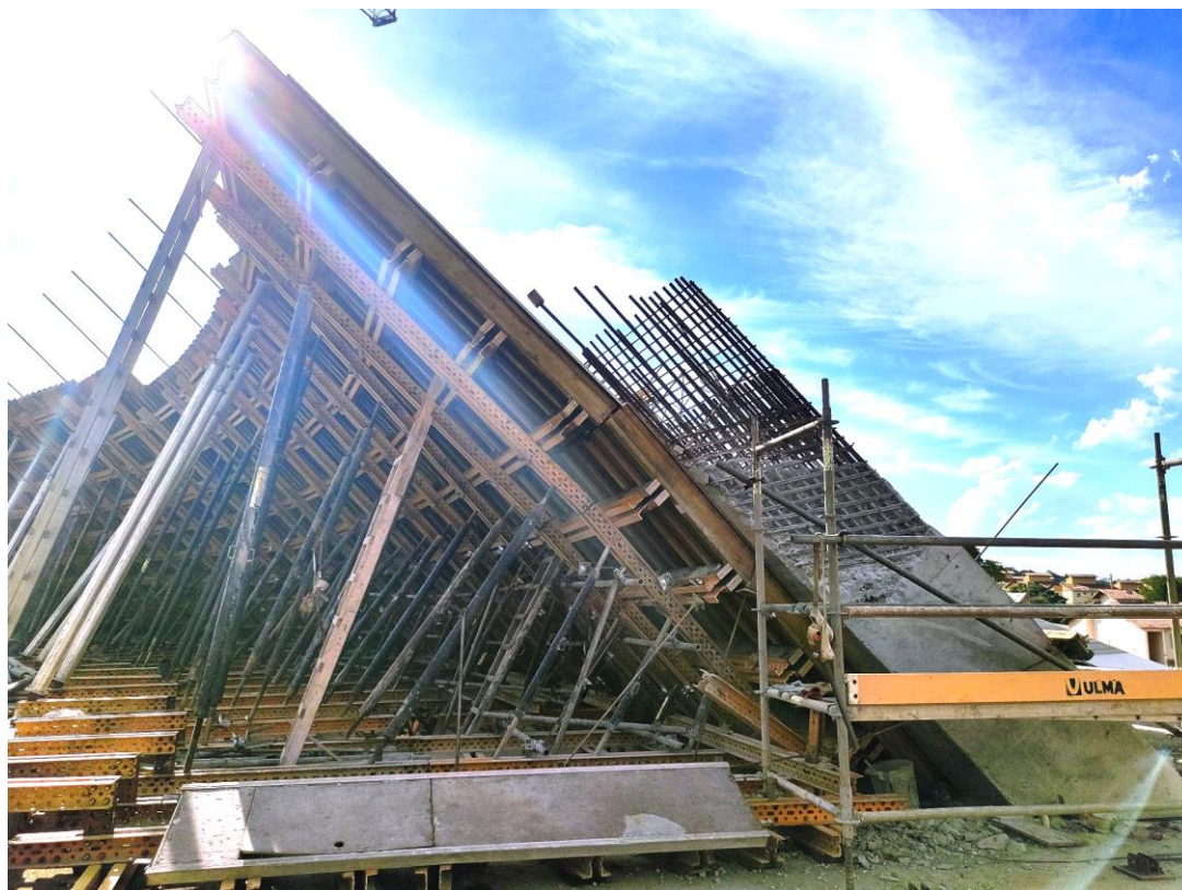
Figura 32: Montagem de fôrmas e concretagem da parede curva
