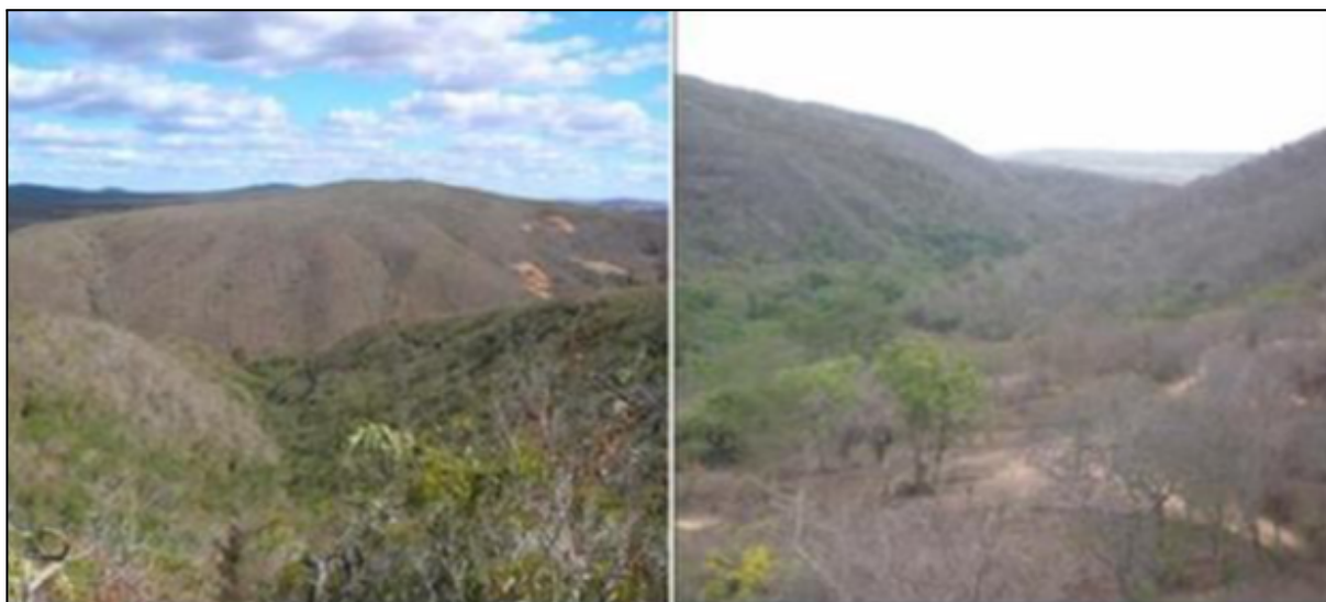
Figura 9 - Vista da área da planta para barragem de rejeito
