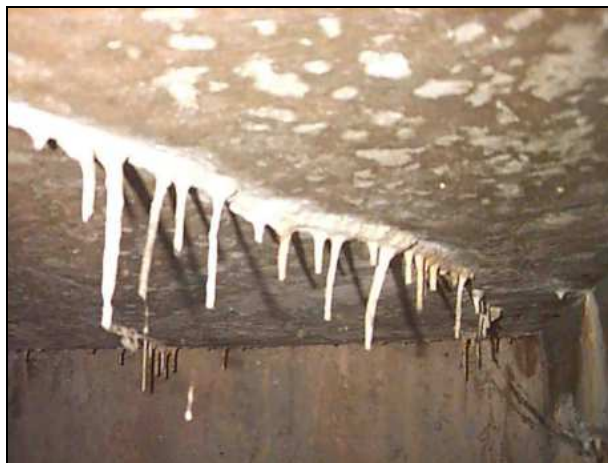
Figura 2.28: Lixiviação da pasta de cimento. Fonte: AGUIAR, 2011.
