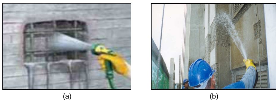
Figura 3.10: Preparo do substrato por molhagem até a saturação, conforme (a) e (b). Fonte: AGUIAR, 2011.
