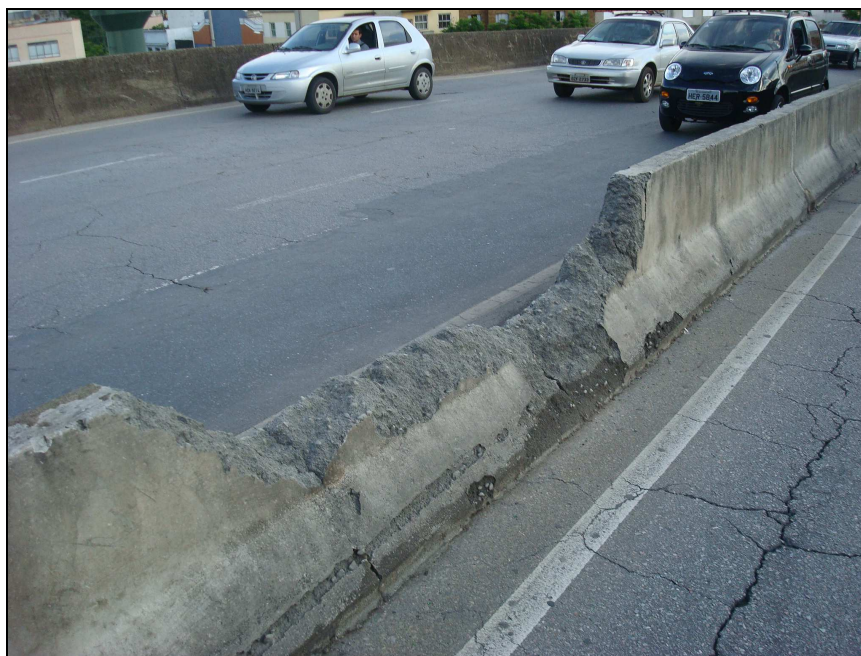
Figura 2.2: Guarda-rodas rompido por batida de veículos em viaduto de Belo Horizonte (MG).
