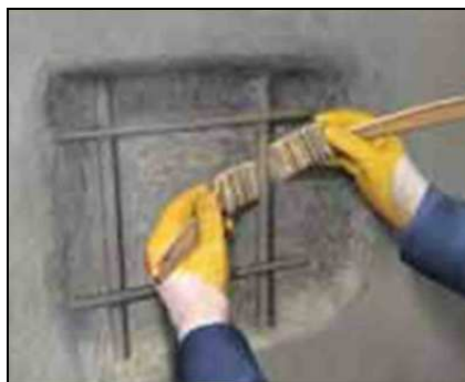
Figura 3.8: Aplicação de argamassa inibidora de corrosão nas armaduras. Fonte: AGUIAR, 2011.
