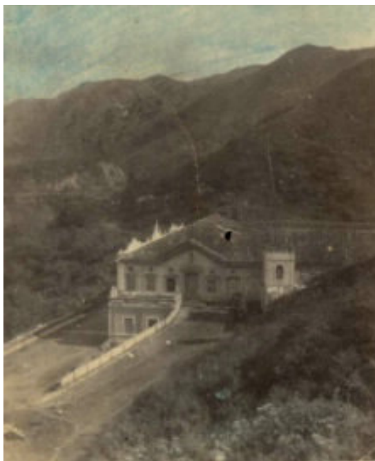
FIGURA 16: Vista lateral da Santa Casa de Misericórdia, no século XIX. 685
