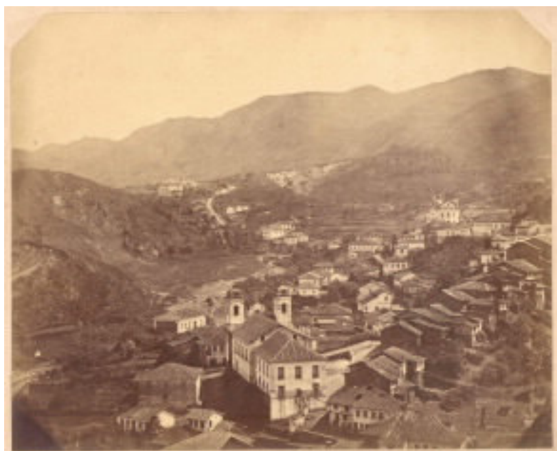
FIGURA 17: Fundo da matriz de Nossa Senhora do Pilar do Ouro Preto.
